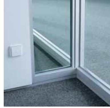
Koridor duvarı - ofis duvarı
