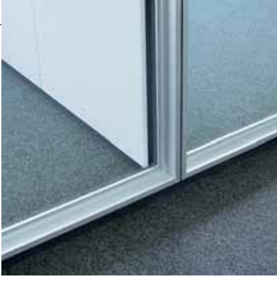
Koridor duvarı - ofis duvarı
